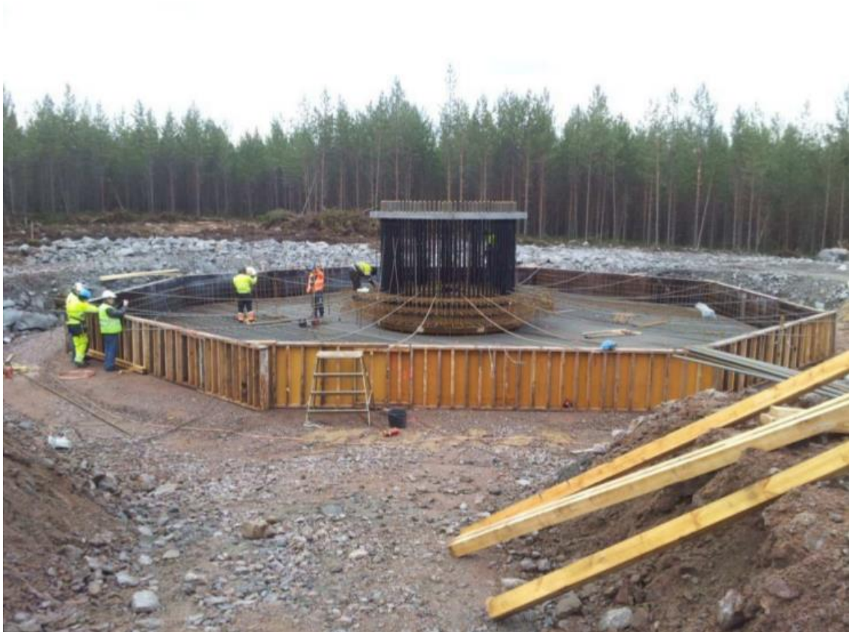
Kuva 22. Tuulivoimalatyömaa (kuva Honkajoelta, kuva Taaleritehtaan)
