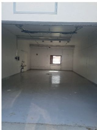
Kuva: Hallitila sisäänkäynnistä
