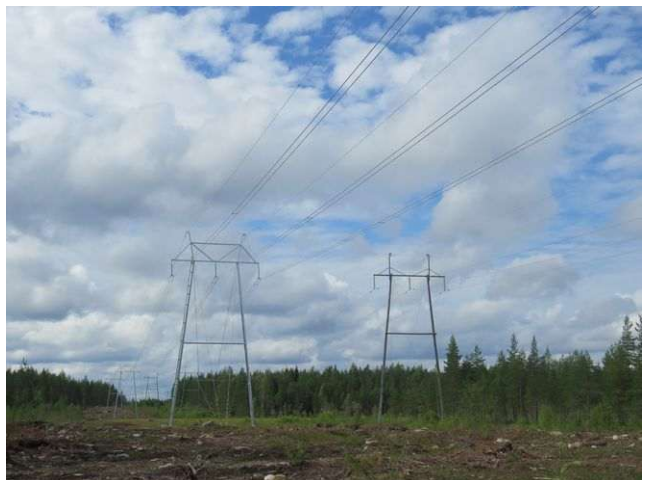
Kuva 32. Voimalinjan käytävä Pienen Piuharjun kohdalla, länsilounaaseen.
