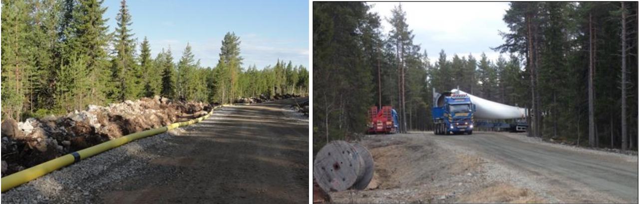
Kuva 76. Vasemmallalla kuvassa on esimerkki tuulivoimapuiston rakennus- ja huoltotiestä. Teitä käytetään muun muassa betonin, soran ja voimaloiden komponenttien kuljetuksiin sekä tuulivoimapuiston käyttöväheessä huoltoajoihin. Maakaapeli sijoitetaan ojakaivantoon tien reuna-alueelle. Oikealla kuvassa tuulivoimalan osia kuljetetaan erikoiskuljetuksina. (Kuvat: Ville Suorsa / FCG).
